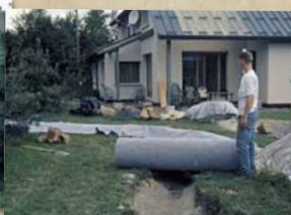
Pose d'un géotextile sur un lit de sable
